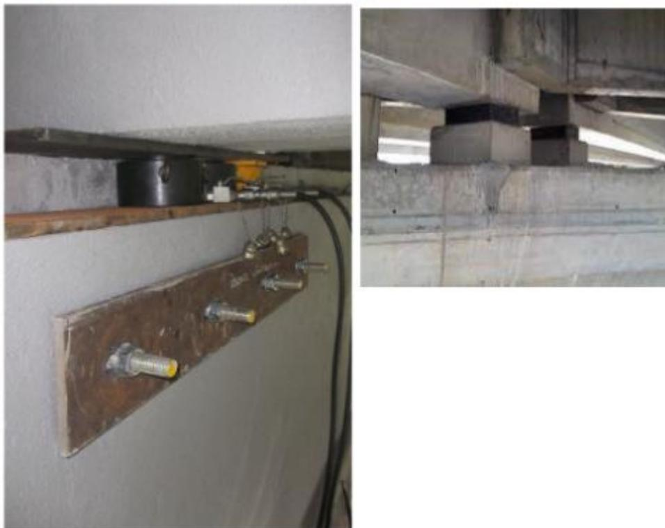
Figura 2: esempio intervento sostituzione appoggio
