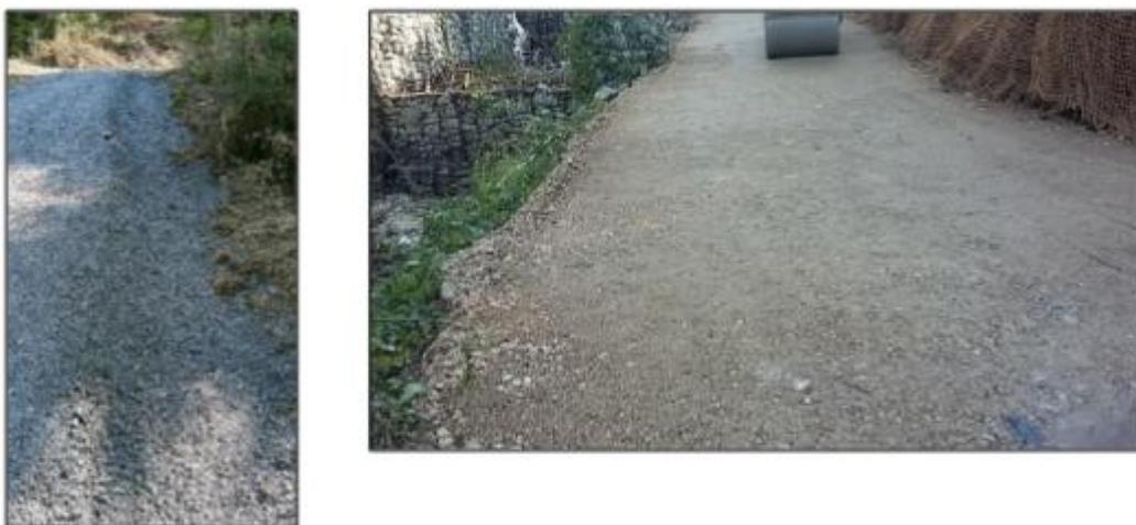
*Figura 6 – esempi di sottofondo stradale realizzato con materiale naturale compattato e tout-venant*
